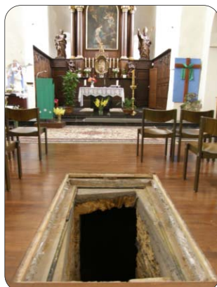
Dans la grande nef, la trappe d'accès enlevée.
