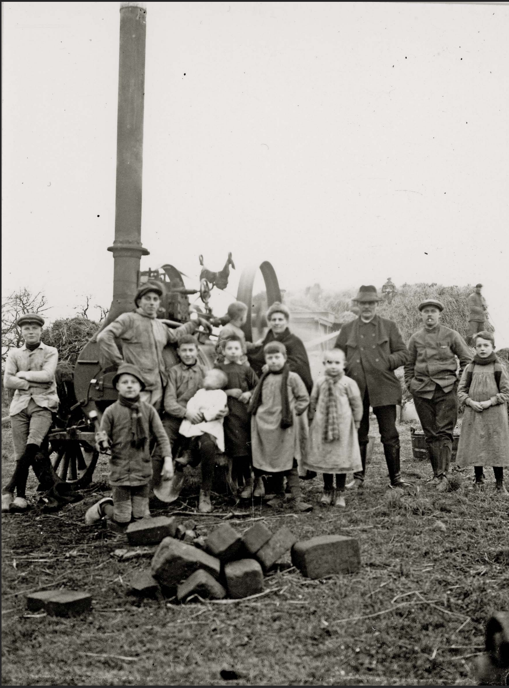
On bat à la machine en pâture grâce à une locomobile (en quelque sorte une petite locomotive). De grosses briques de charbon alimentent cet engin à vapeur. On peut entre autres y reconnaître: René Dumont, Alphonse Ninane, René Jacquet, Gilbert Ninane, Georges Jacquet et Arthur Russelle. À l'avant-plan, agenouillé: Lucien Dumont.
