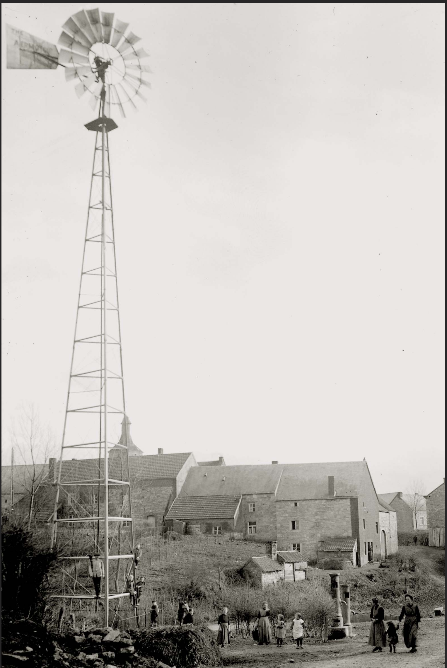
Vers 1910, une Aermotor (éolienne venant du Texas) fut installée au village au lieu-dit bien nommé «La Fontaine». Son rôle était de pomper l'eau du puits et de la propulser au-dessus du village dans un château d'eau expressément aménagé. Cette réserve haute d'eau desservait tout Tohogne grâce un réseau de bornes-fontaines installées dans chaque quartier. De jeunes garçons, bravant l'interdit, ne résistaient pas à l'envie de grimper à l'échelle conduisant au sommet, celle-ci étant cependant réservée au préposé qui graissait périodiquement les roulements de l'éolienne.
